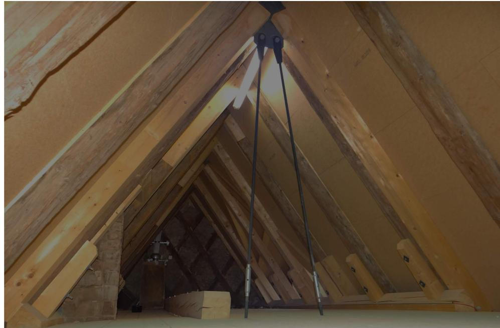
*Aufwendige technische Sicherung des Dachstuhls und somit der Statik des Gebäudes (2012)*
